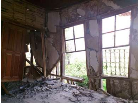
Şekil 15. Ali Manav Evi yapım sisteminde bozulmaların olduğu misafir odası.(İnce, 2011)
