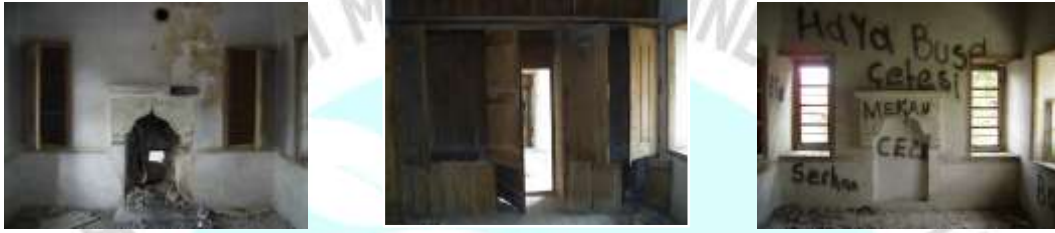
Şekil 9. Ali Manav Evi ; 2 numaralı mekandaki odalardan detaylar (İnce, 2011)
