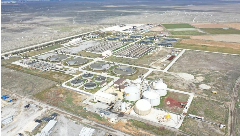
Görsel 1. Konya Atıksu Arıtma Tesisi
