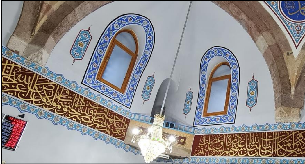
Görsel 5. Kubbeye geçişte kullanılan tromp ve yazı kuşağı
