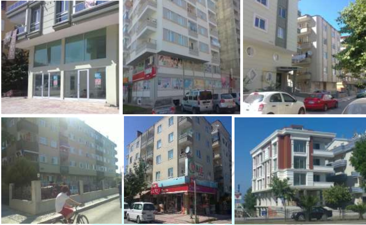
Şekil 2. Asma kat, Yüksek giriş, Yumuşak kat örnekleri
