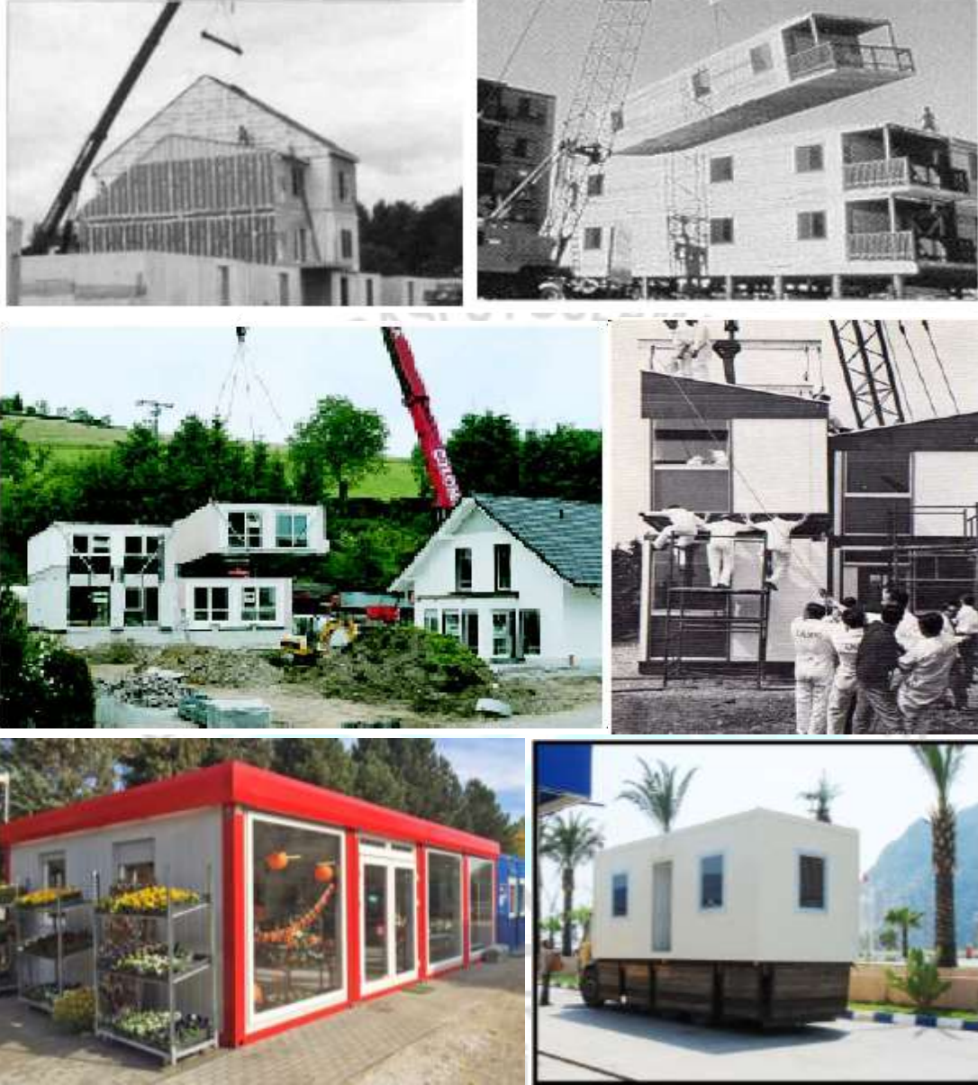
Şekil 5. Hafif çelik modüler (hücreyel) inşa örnekleri [9] [13] [14]
