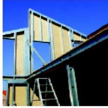
Şekil 6. Hafif çelik konutlarda, yığma yapılar gibi, boşluk oranlarının az olması gerekir [9].
