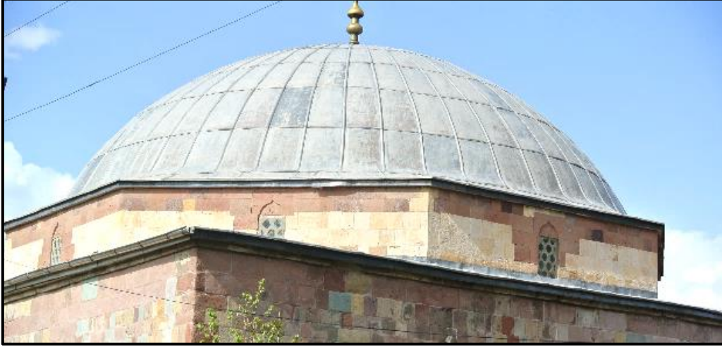
Görsel 20. Kubbe kasnağı ve pencereleri
