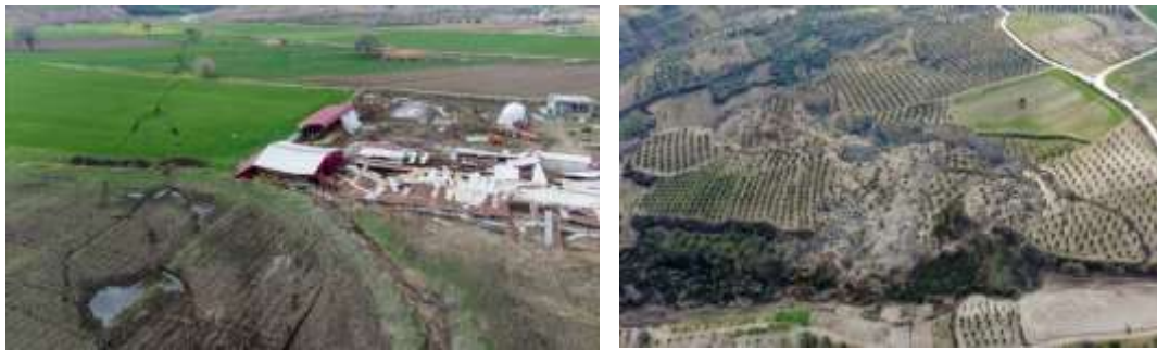
Görsel 2. Depremi nedeniyle oluşan kayma ve çökme [7]
